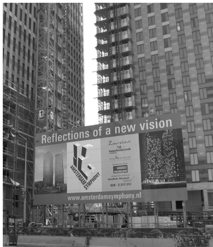
De Zuidas in aanbouw; een miljarden verslindende ruimtelijke interventie
